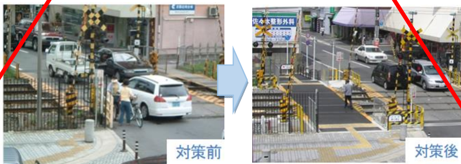
写真 2-1-26 踏切拡幅（歩道新設）の例
