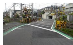
踏切道内の車道外側線
