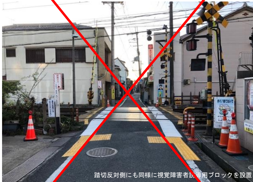
写真 2-7-8 踏切道手前部に視覚障害者誘導用ブロックを設置した事例
