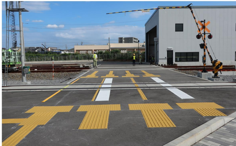
図● 本実験の誘導表示等の敷設状況
