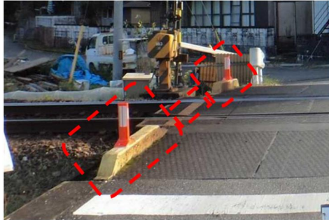
写真 2-7-● 踏切道端部のブロック、ラバーポール及び路面標示の設置事例
