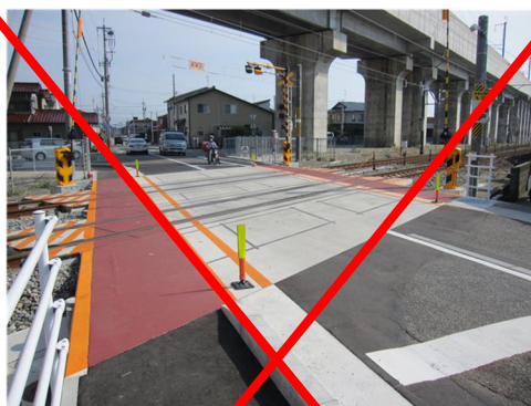
写真 2-1-28 カラー舗装の例
