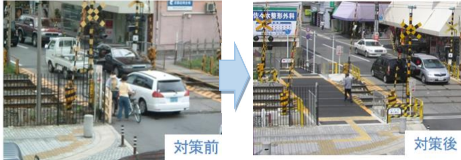
写真 ● 踏切拡幅（歩道新設）の例
