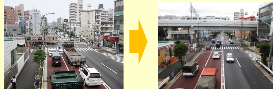
環状第4号線(明治通り)の踏切
