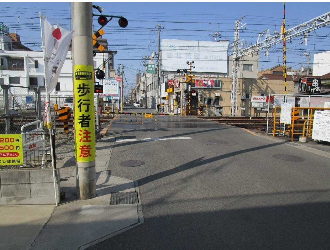
飾磨踏切 (兵庫県姫路市飾磨区清水)
