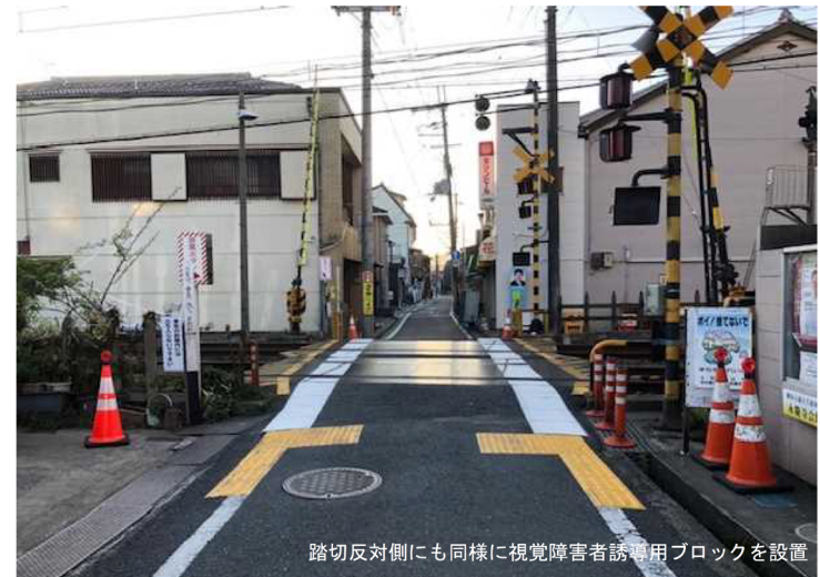
図 2-7-8 踏切道手前部に視覚障害者誘導用ブロックを設置した事例
