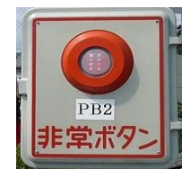
非常押しボタン
