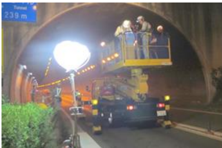
トンネル点検車による点検
