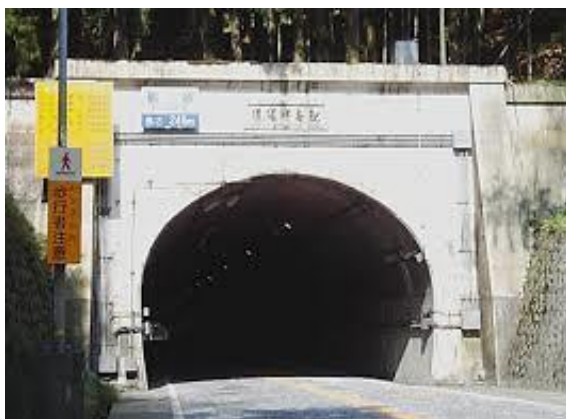
国道9号 観音トンネル（矢板工法 1935年完成 供用年数 88年）
