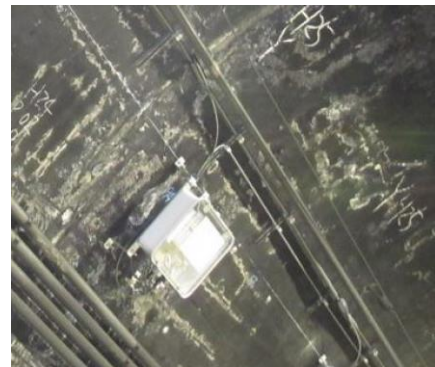
灯具の交換に合わせて 固定金具を腐食に強いステンレスに交換 ＝脱落防止
