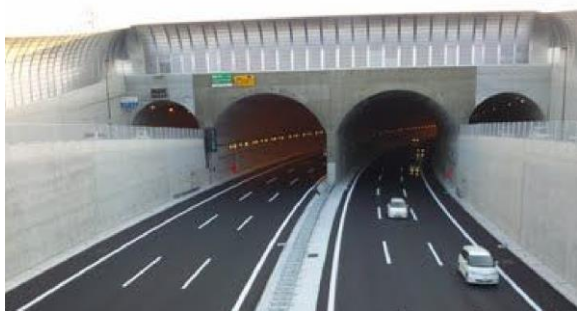
国道1号 寝屋川トンネル L=780m
