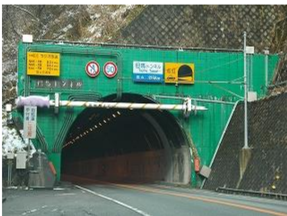
国道9号 但馬トンネル（矢板工法 1965年完成 供用年数 58年）
