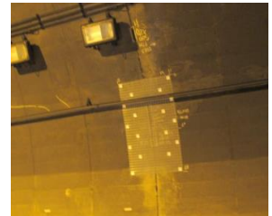
剥落防止ネット工
