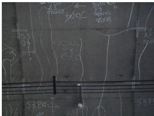
国道26号泉南トンネル ひび割れ補修+剥落防止（平成29年度）
