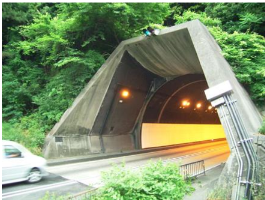
国道161号 長等トンネル下り L=1,305m
