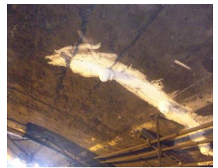
ひび割れ注入
