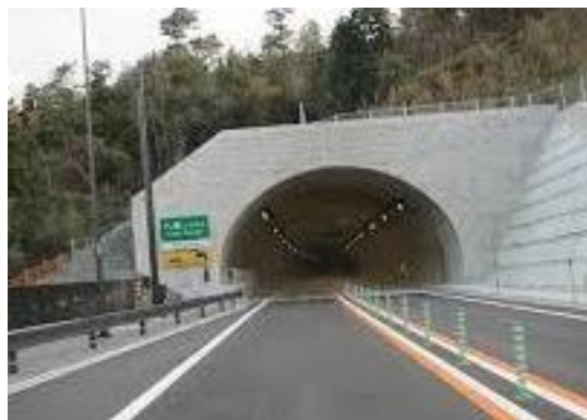
国道483号 八鹿トンネル L=2,990m 近畿地方整備局管理で最も長い国道トンネル
