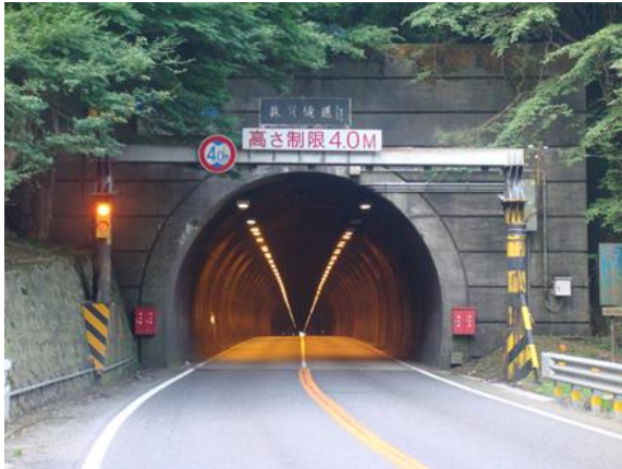
国道8号 敦賀トンネル（矢板工法 1962年完成 供用年数 61年）
