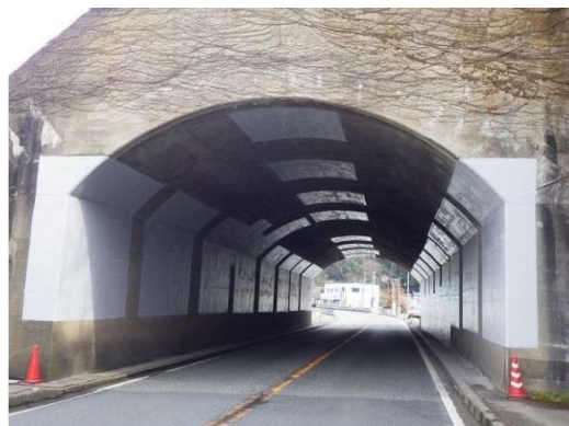
国道9号 城山トンネル L=38m
