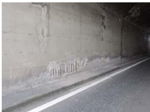
国道9号城山トンネル 断面修復・剥落防止工（平成28年度）
