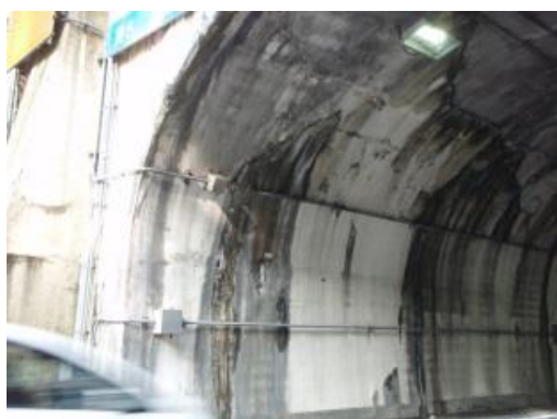
国道9号観音トンネル 繊維シート補強工（平成30年度）
