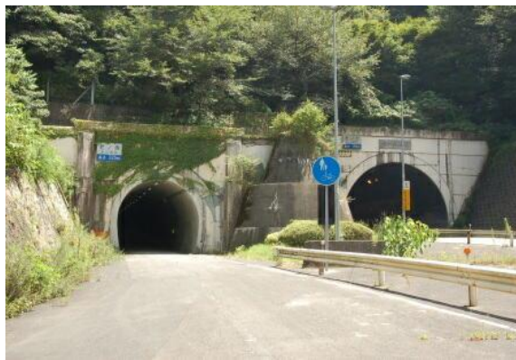
国道9号 老ノ坂トンネル L=225m
