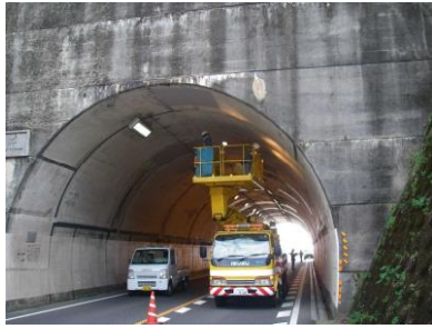
トンネル施設点検状況
