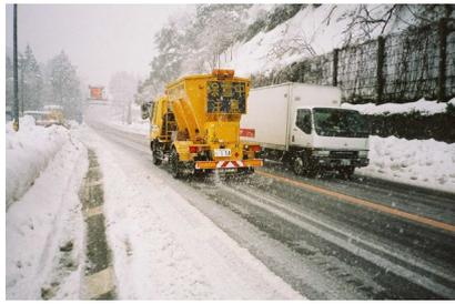
凍結防止材の散布作業
