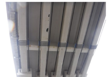
断面修復 外ケーブル補強
