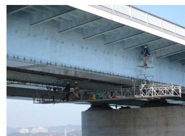
移動式吊足場による点検
