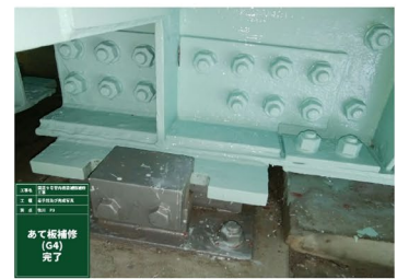
あて板補強と支承の交換
