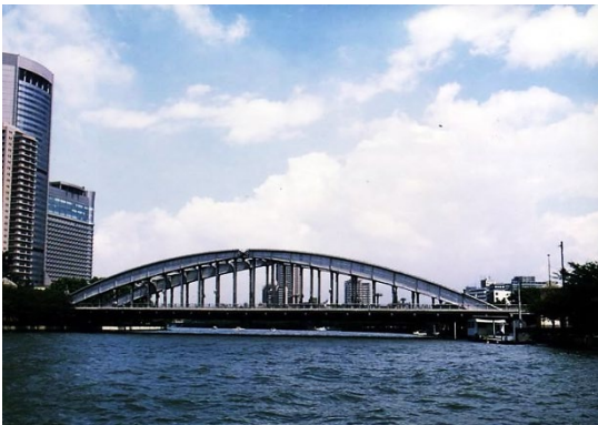
国道 1号 桜宮橋 (単純鋼リベットアーチ橋 1930 年完成 供用年数 93 年 )
