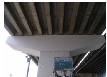
ひびわれ樹脂注入 表面被覆
