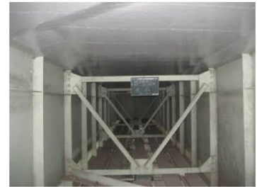
床版下面に炭素繊維シートを接着
