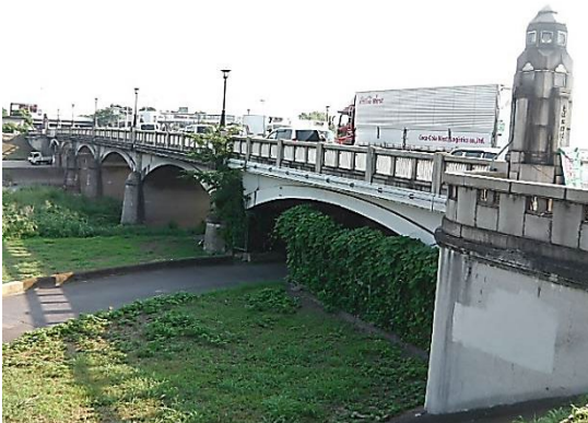
国道 1号 鳥羽大橋 (6 径間連続RCアーチ橋 1934 年完成 供用年数 89 年 )
