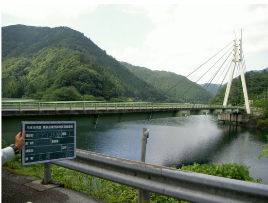
国道29号 カラウコ大橋(単径間鋼斜張橋(箱桁))
