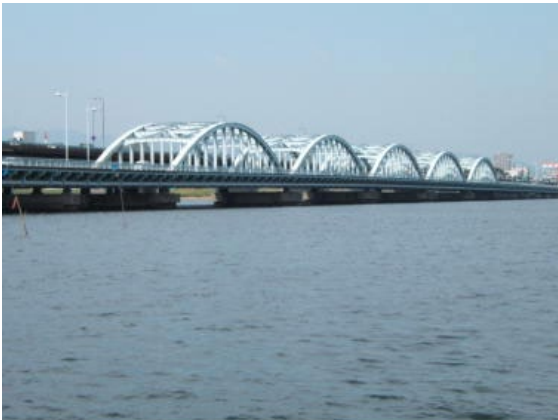
国道43号 伝法大橋(鋼ランガーアーチ橋)
