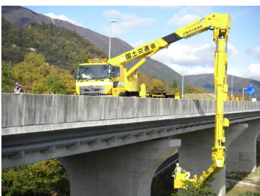
橋梁点検車による点検
