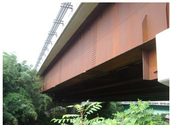
国道175号 天神橋(単純鋼非合成版桁橋)
