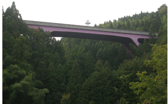
国道27号 塩出橋(3径間連続鋼溶接方杖ラーメン橋)
