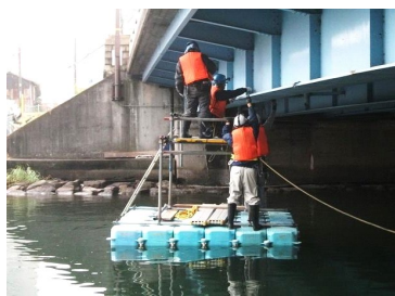
船(フロート)による点検
