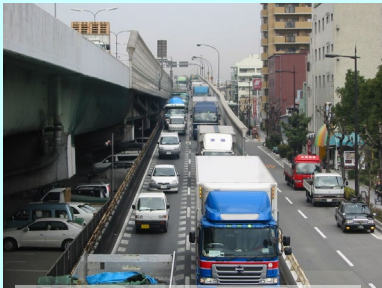
大型車の多い大阪市内の交通状況 (国道43号安治川大橋ランプ橋)
