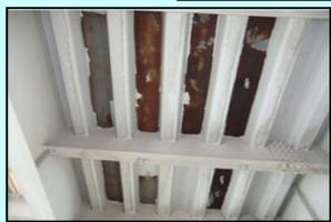
最下層の塗膜まで劣化したため、下地処理(錆落とし等)に多大な費用を要する
