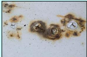
腐食が孔食(錆びて穴が開く)まで進行したため、部材の取り替えが必要となる
