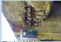
■コンクリート部材の剥離・鉄筋露出
