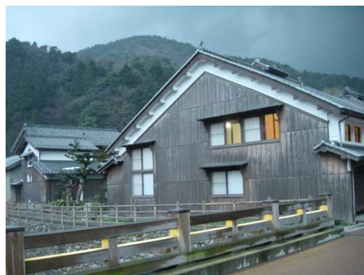
修復後の旧逸見勘兵衛家(平成 16 年)
