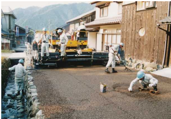
地道風舗装工事の様子
