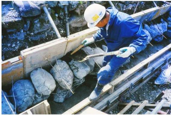
石積護岸工事の様子
