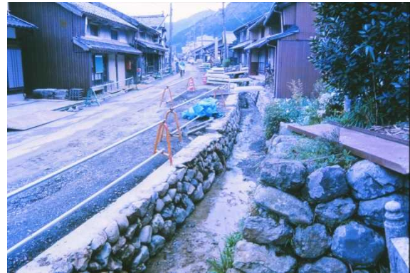
石積護岸の復元
