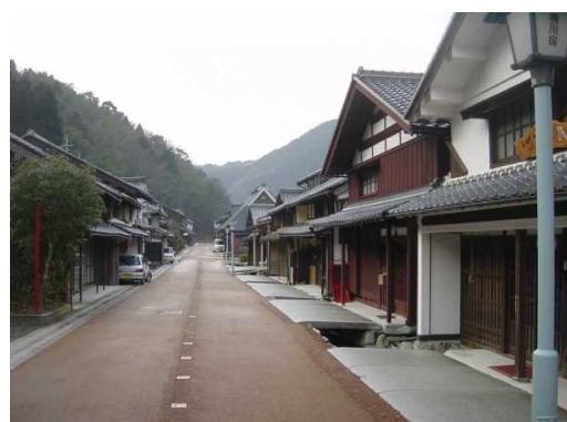
整備後の様子(平成20年)
