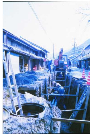
無電柱化工事の様子
