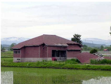
廃屋撤去前(旭川市西神楽)
