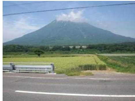
防雪柵更新後(京極町)
