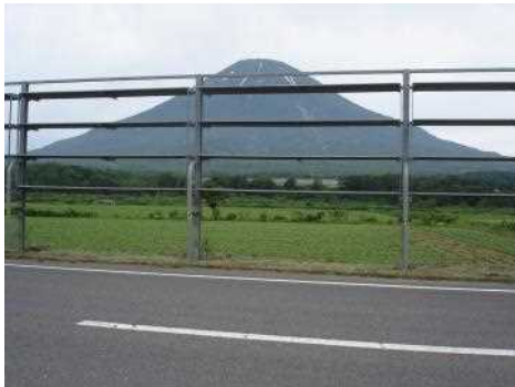
防雪柵更新前(京極町)
