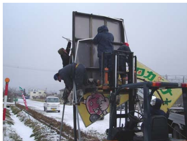
不要看板の撤去(壮瞥町)
