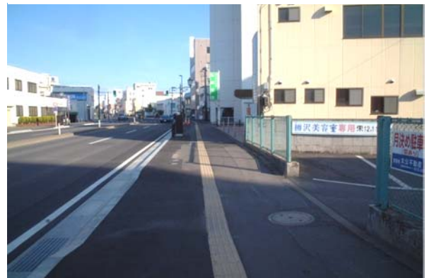
【県道弘前鱒ヶ沢線 整備済み工区】
