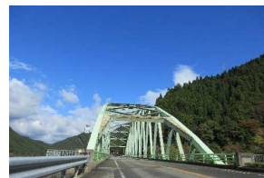
国道29号にかかる橋
