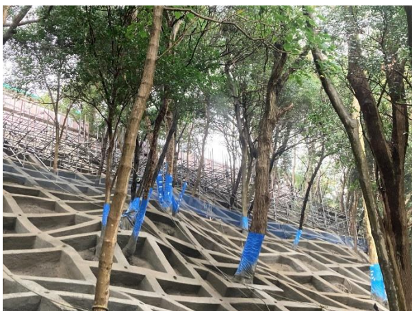
写真-1 西側斜面：斜面南側より撮影
