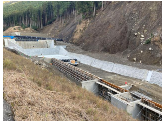
施工状況【流路】
