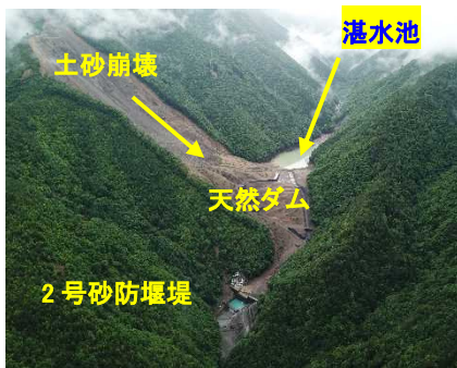
写真1. 河道閉塞 (下流より)
