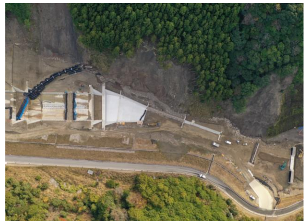
施工状況 空撮【流路】
