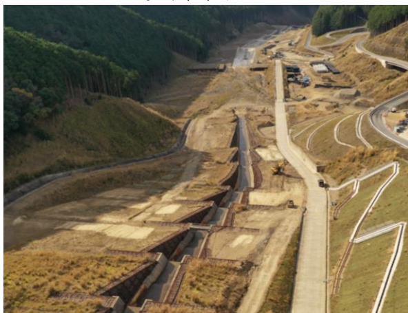
施工状況 空撮【落差工】
