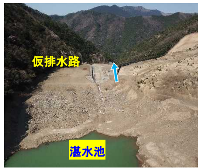
写真2. 河道閉塞 (上流より)
