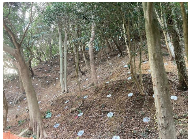
写真-2 東側斜面：斜面西側より撮影
