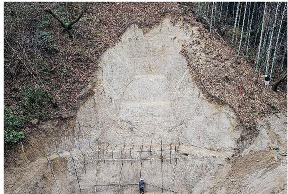
チルトローテータによる掘削法面
