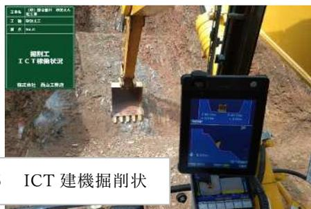
写真-5 ICT 建機掘削状況
