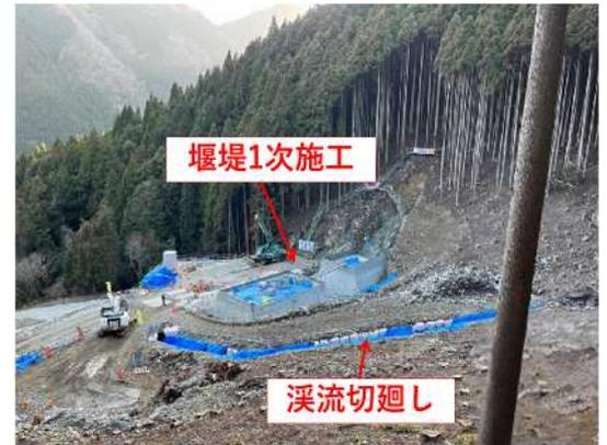
写真-3 堰堤1次施工と溪流切廻しの状況
