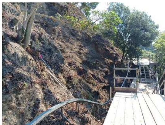
写真-4 斜面下側モノレール増設
