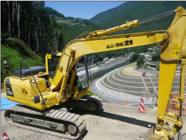
種別:掘削工(ICT) 状況説明:マシンガイダンスバックホウ
