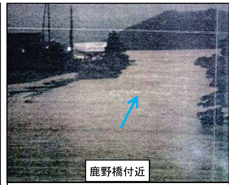
鹿野橋付近 平成10年台風7号による被害 『浸水家屋 61戸、浸水面積 約184ha』
