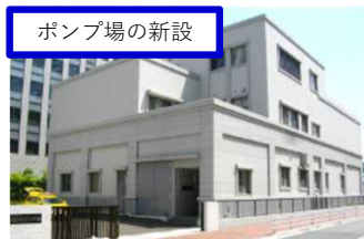
中突堤ポンプ場(中央区)
