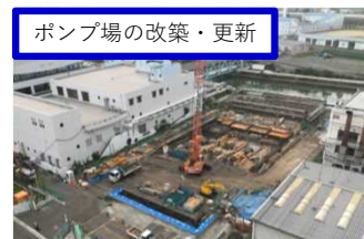
魚崎ポンプ場(東灘区)
