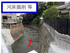
妙法寺川(板宿工区)
