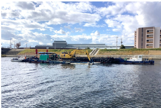
戸ノ内地区河道掘削(国土交通省)
