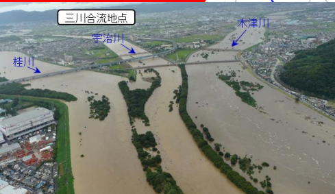
平成25年台風18号洪水時の三川合流点の状況 ※〇〇川は、整備中または整備予定の府・政令市管理河川を示したものである。 ※他の事業者の計画も見直されれば、同様に反映します。 ※新たな関係者にも広く参加を呼びかけることから、新たな関係者の計画も反映しました。
