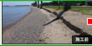
湖岸保全（砂浜浸食対策：養浜）
