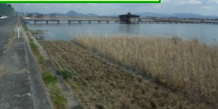
水質改善（植生護岸工）
