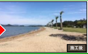
湖岸保全（砂浜浸食対策：養浜）
