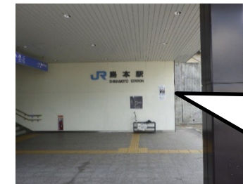
浸水深2.2mJR島本駅東口
