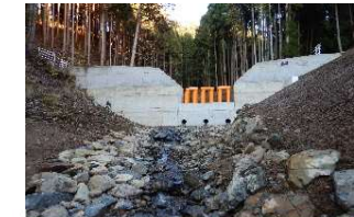
部分透過型治山ダムの設置 (兵庫県 朝来農林振興事務所)
