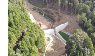
砂防堰堤の設置 (兵庫県 養父土木事務所)
