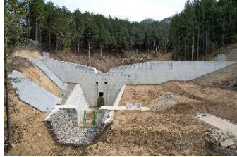
砂防堰堤の設置 (兵庫県 豊岡土木事務所)
