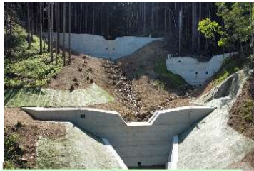
治山ダムの設置 (兵庫県 豊岡農林水産振興事務所)
