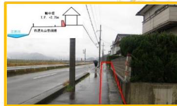
江古川地区の輪中堤整備 (福井県)
