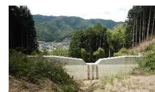
治山ダムの設置 (兵庫県 光都農林振興事務所)
