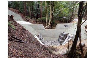
治山ダムの設置 (林野庁 兵庫森林管理署)
