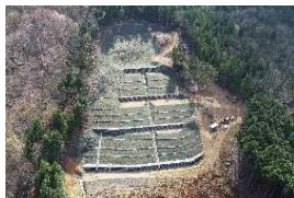
荒廃山地復旧により保水機能を高める山腹工事 (林野庁 兵庫森林管理署)
