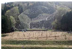
山腹崩壊箇所の復旧対策の実施 (兵庫県 光都農林振興事務所)
