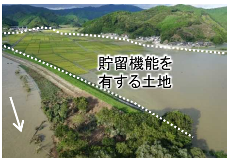
貯留機能を有する土地のイメージ (平成28年台風16号 北川水系北川 家田地区)
