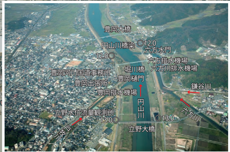
▼立野大橋付近
