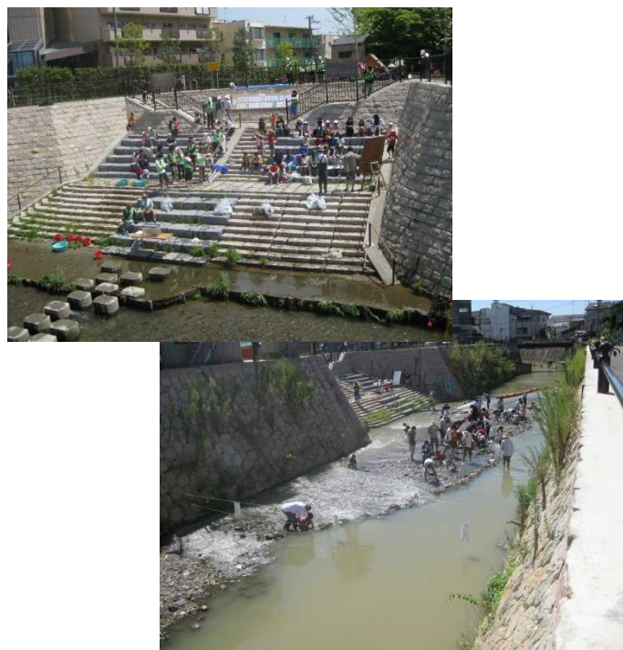
写真2 一体整備された構口公園と階段護岸
