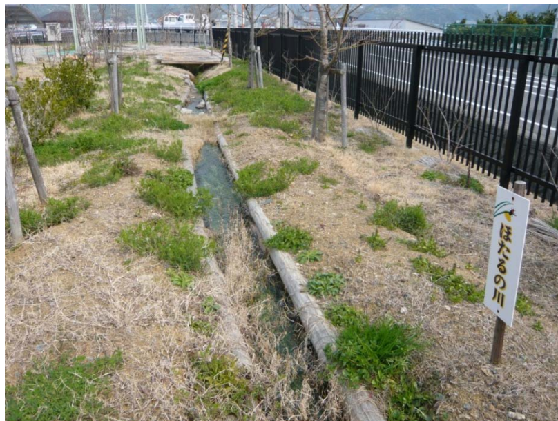
吉備浄化センター「水ホタル」敷地内の水路の写真
