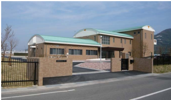
吉備浄化センター「水ホタル」の写真
