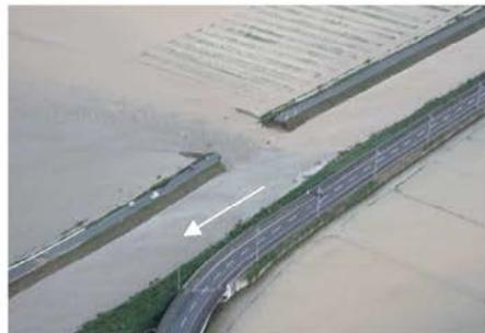
写真-1 破堤状況 (野木川)
