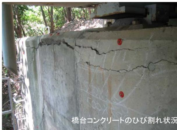
橋台コンクリートのひび割れ状況
