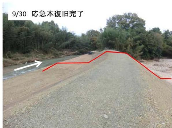
図 2. 鴨川破堤地点および応急復旧状況
