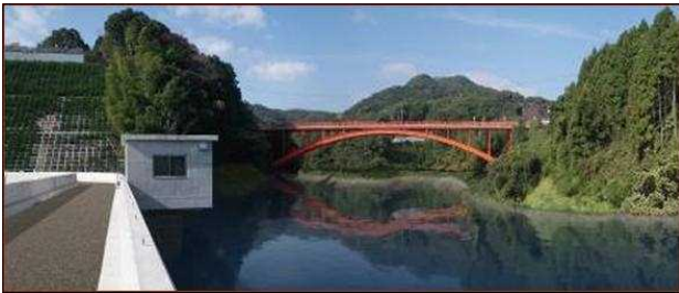
写真2：堤体左岸側よりダム湖を望む
