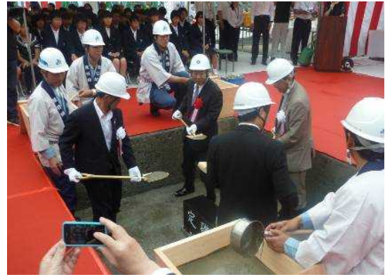
写真-4 鎮定(ちんてい)の儀 礎石を固めるためモルタルを礎石の基礎に入れる儀式 工事を進める道をつけるという意味がある
