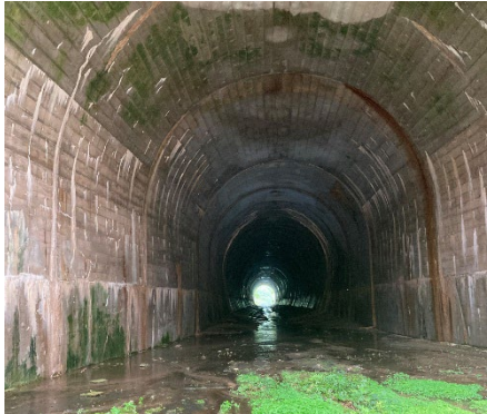
排水トンネル
