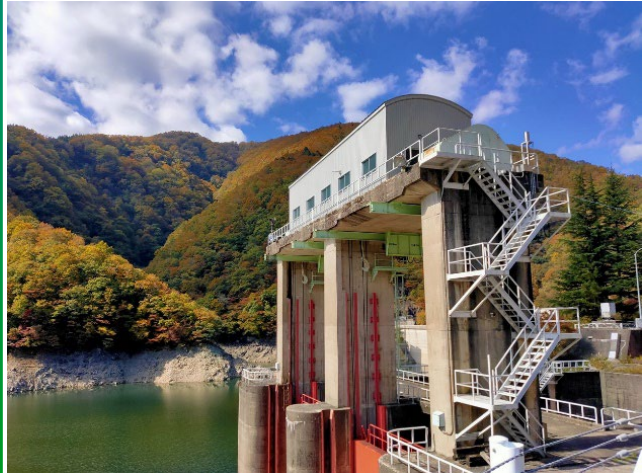
余水吐きゲート
