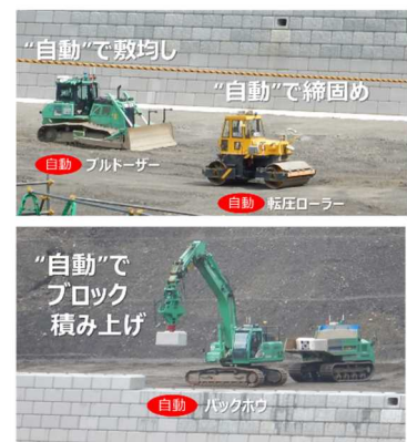
図-5 赤谷地区での自動化施工
