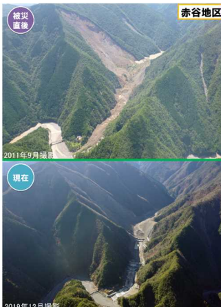
図-3 赤谷地区施設整備状況
