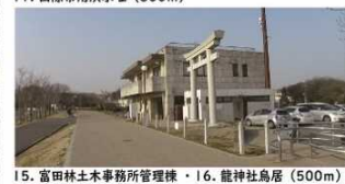
15. 富田林土木事務所管理棟・16. 龍神社鳥居 (500m)
