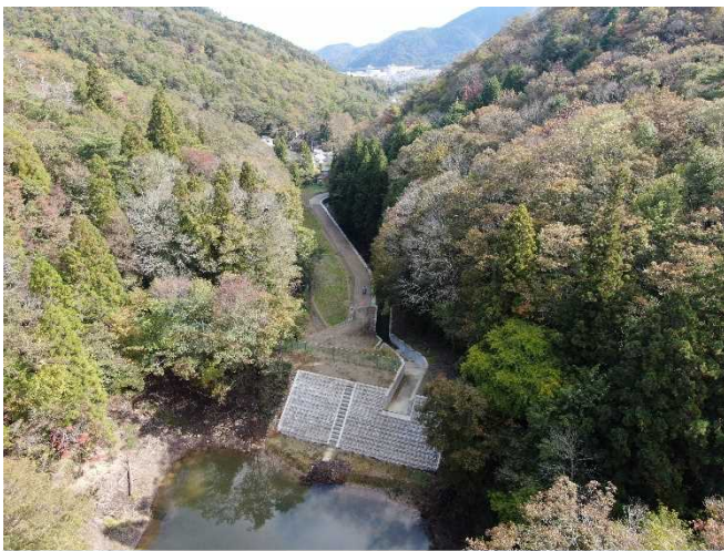
写真-2 鎌ヶ谷大池完成写真①
