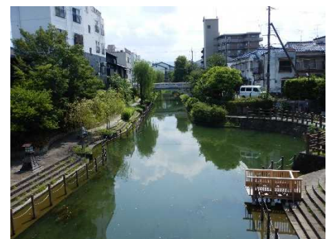
写真-1 宇治川派流と港湾施設
