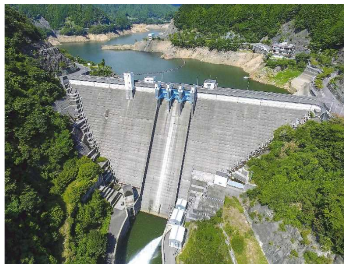
写真-5 安濃ダム (利水ダム)
