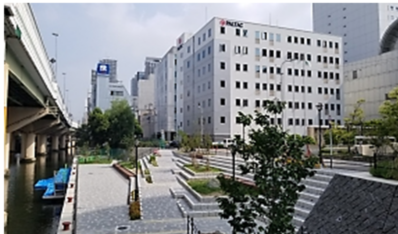
写真－1 本町橋BASE全景（β本町橋設置工事前）
