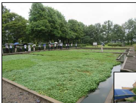
赤野井湾流域流出対策施設 （水生植物による浄化施設）
