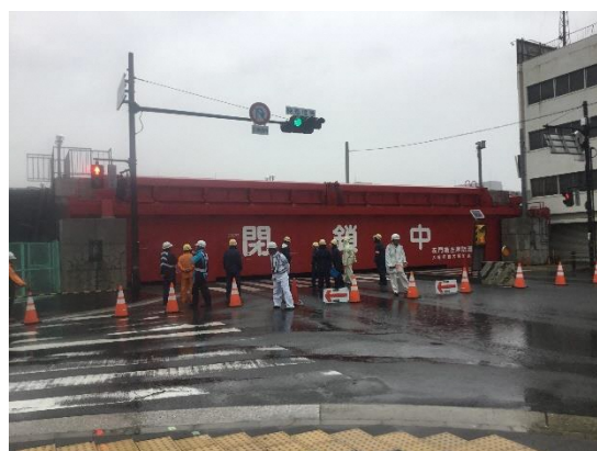
写真-2 国道2号鉄扉の閉鎖状況
