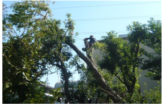
撤去作業の様子
