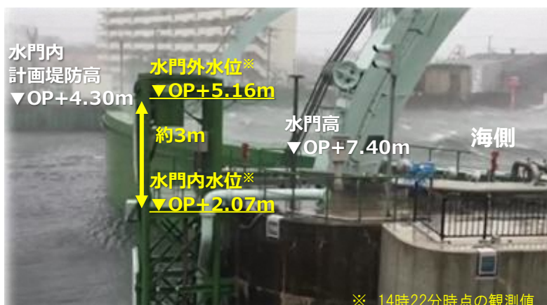
写真-1 木津川水門の閉鎖状況
