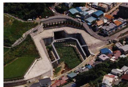
写真-5 放水路入口(沈砂池)
