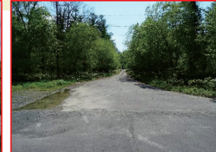
周辺の樹木が生い茂りビルケの森に到着したかわかりづらい。
