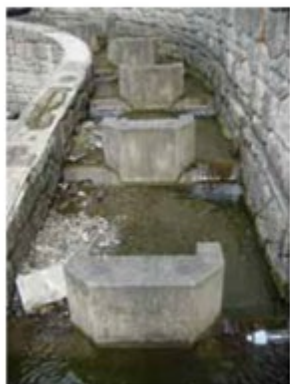
<魚道下流部で河床低下が生じている魚道>
