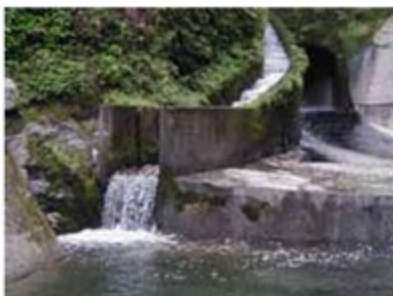
<魚道下流部で河床低下が生じている魚道>
