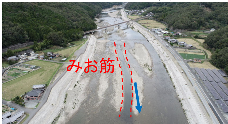
みお筋掘削後(R3年度)
