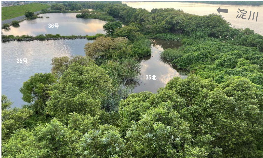
① 菅原城北大橋下流 (R4.7.26撮影)
