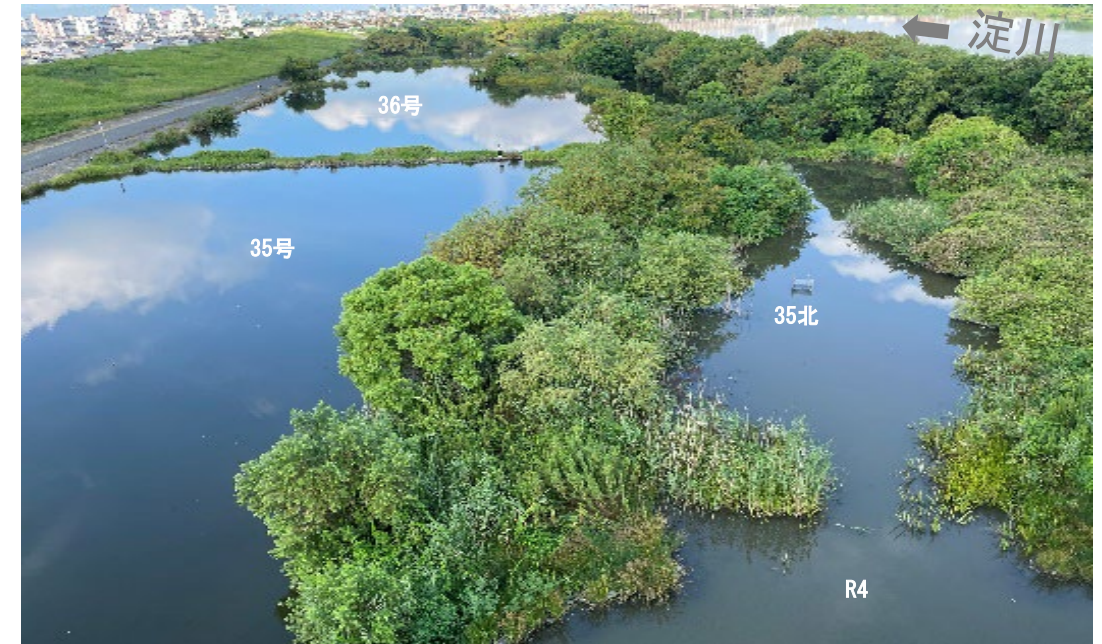
① 菅原城北大橋下流 (R6.8.22撮影)
