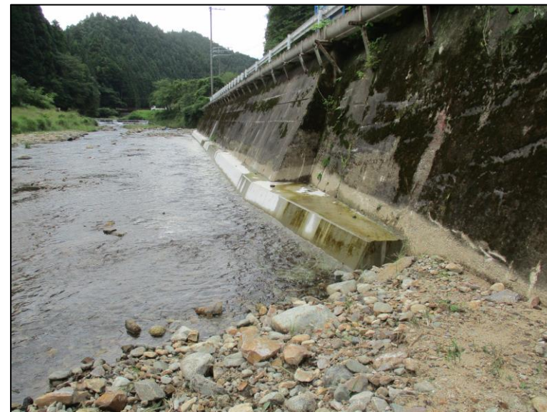
工事施工・完了
