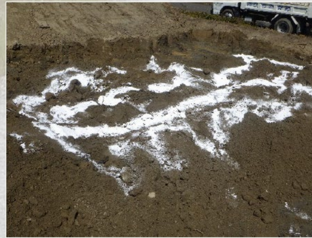
改良土の製作(アルカリ性改良)
