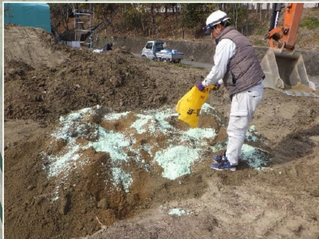
改良土の製作(酸性改良)
