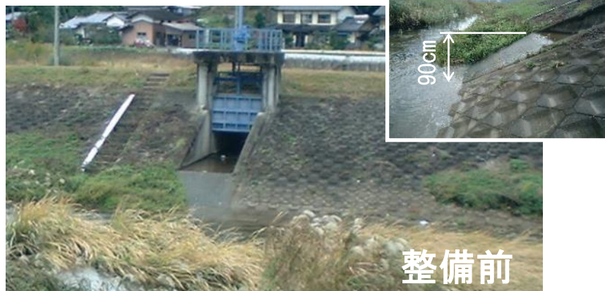
八代川 竹貫川樋門(八代川約3km地点)
