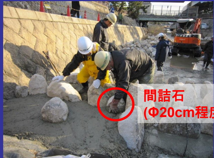
②間詰石を設置
