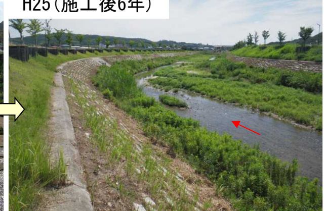
H25(施工後6年)
