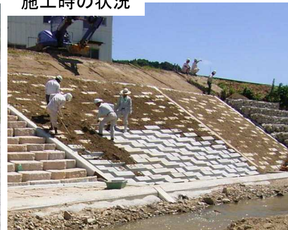
施工時の状況
