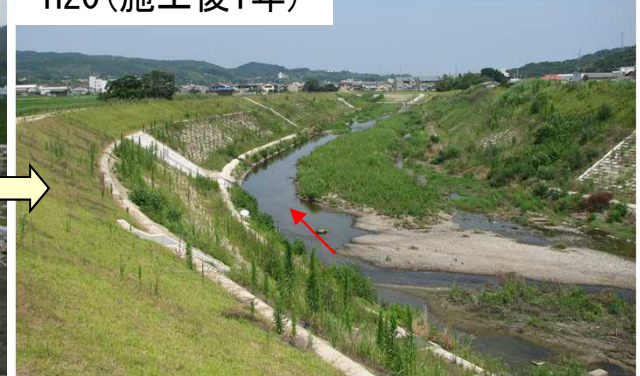
H20(施工後1年)
