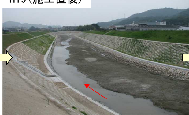
H19(施工直後)
