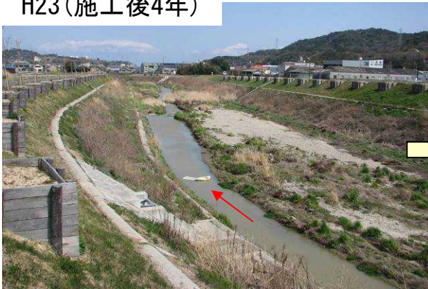
H23(施工後4年)
