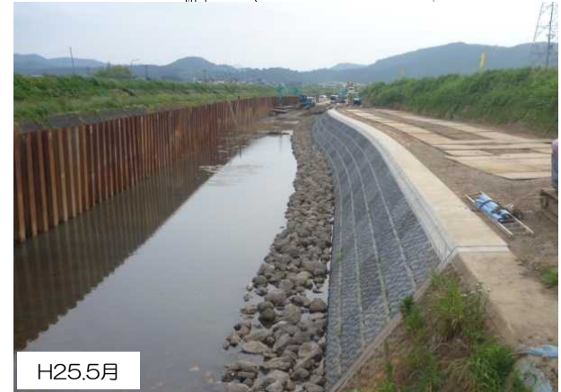
捨て石施工完成状況
