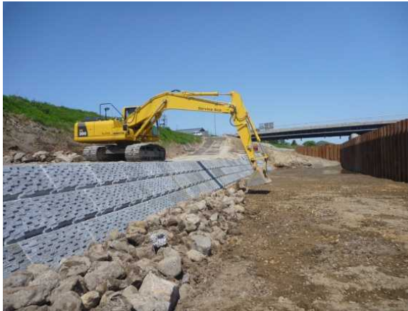
捨て石施工状況
