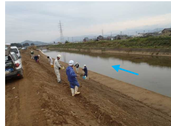
手撒き作業状況
