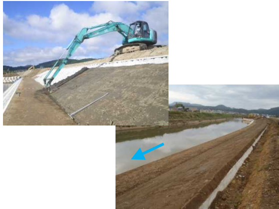
高水護岸（覆土）施工・完成状況
