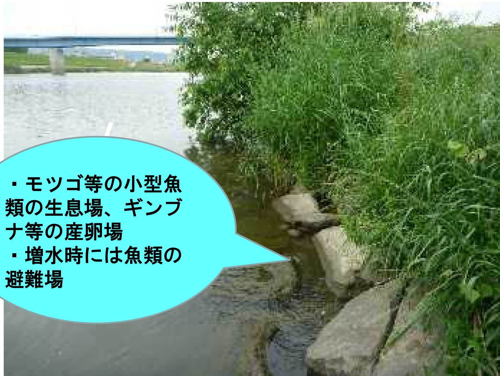
空石積護岸に定着したヤナギ、セイタカヨシ(左岸15.8k)
