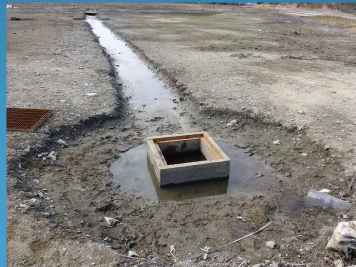
窪地 と ポンプの吐出口 /新浜ビオトープ
