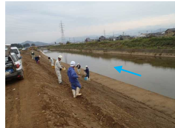
手撒き作業状況
