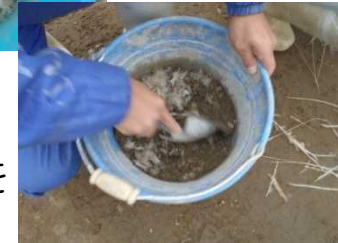
種子と土砂を混ぜ込み
