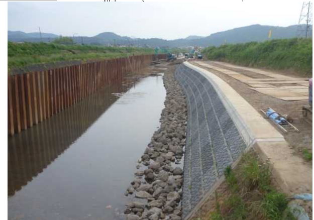
捨て石施工完成状況
