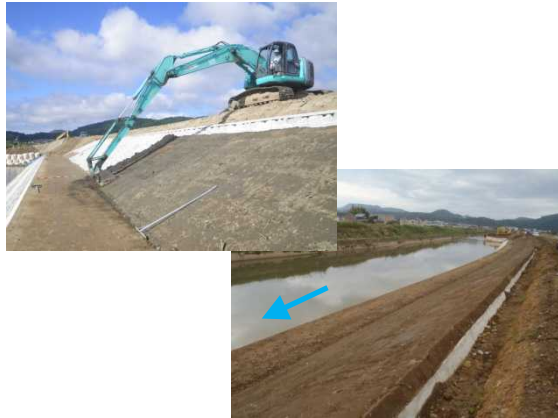
高水護岸（覆土）施工・完成状況
