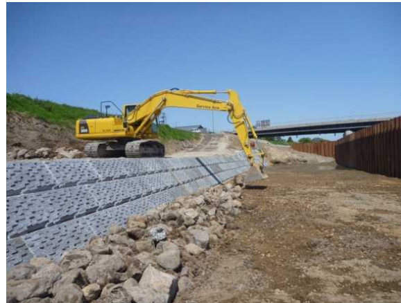
捨て石施工状況
